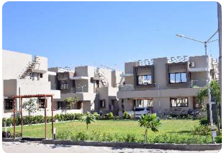
Actual Site Progress Photos
